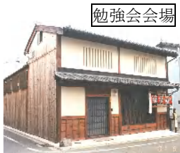
勉強会会場 江戸期の町家の伝統構法による防火・耐震改修 (1999-2000)
